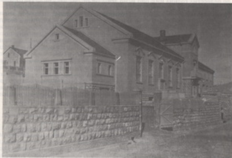
Зграда Дома културе у Бору (данас факултет) у којој је била смештена синдикална књижница са читаоницом
