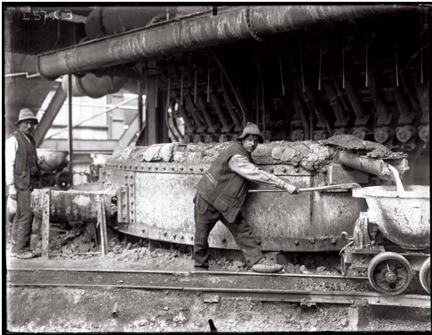
Сл. 27. [Портрет радника у топионици Француског друштва Борских рудника. Истакање шљаке из претпећнице „ватер жакетне” пећи у вагонет у старој топионици] Бор, 193?. Црно-бела фотографија формата 20x30 см, штампана на основу негатива из скениране колекције негатива Љубе Маркова и фото-документације Француског друштва Борских рудника. Формат негатива на стакленој плочи – 18x24 см. З Ф I 86. COBISS.SR-ID: 512718776
