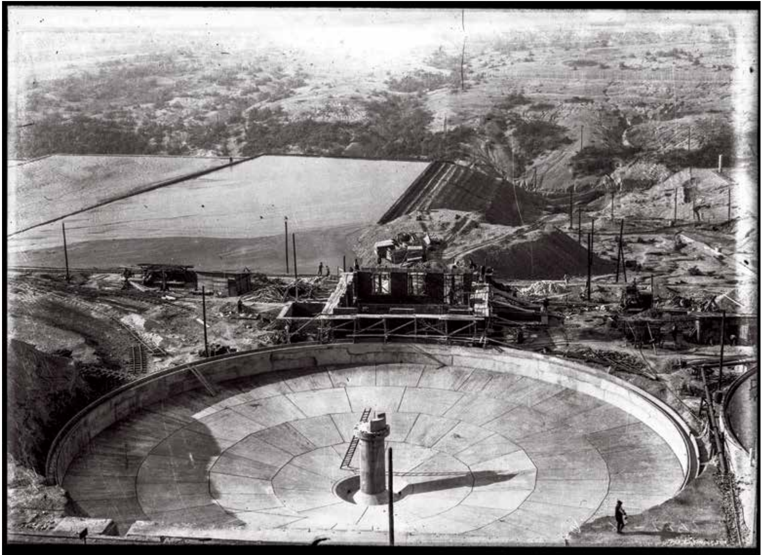
Сл. 34. [Флотацијски базен у Борским рудницима. Згушњивач борске флотације] Бор, 193?. Црно-бела фотографија формата 20x30 см, штампана на основу негатива из скениране колекције Љубе Маркова и фото-документације Француског друштва Борских рудника. Формат негатива на стакленој плочи – 13x18 см. 3 Ф I 83. COBISS.SR-ID: 51255448
