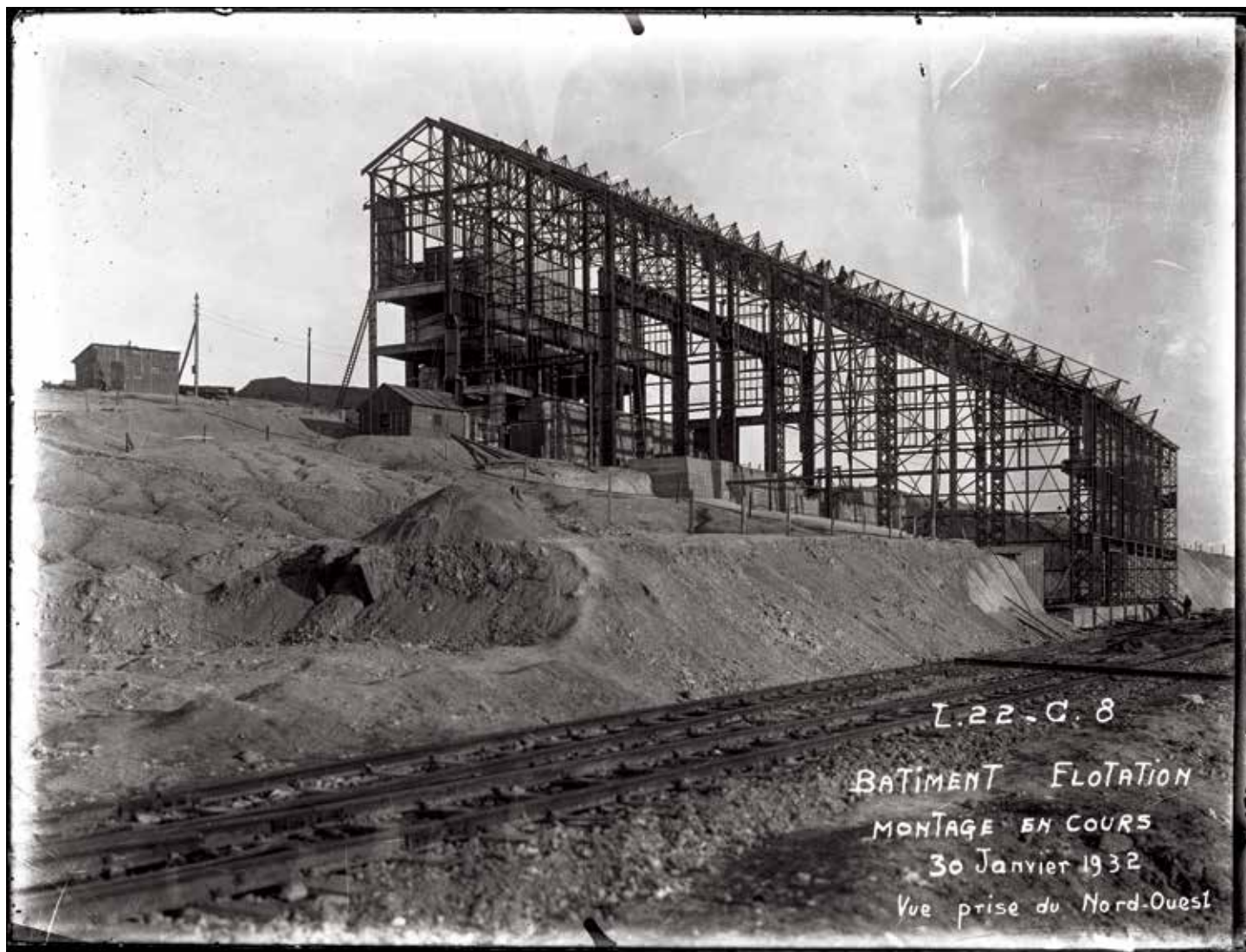
Сл. 31. Batiment Flotation montage en cours 30. janvier 1932. vue prise du Nord-Ouest. Бор, [Зграда Флотације у изградњи, 30. 1. 19332, поглед са северозапада] Црно-бела фотографија формата 20x30 см, штампана на основу негатива из скениране колекције негатива Љубе Маркова и фото-документације Француског друштва Борских рудника. Формат негатива на стакленој плочи 18x24 см. З Ф I 21. COBISS.SR-ID: 512422072
